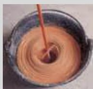
Amasar **webercal fino** con 1,8 litros de agua limpia por bolsa, a batidor eléctrico, hasta obtener una masa fina, untuosa al tacto y exenta de grumos.
