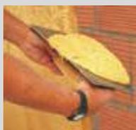
Extender con una llana o proyectar sobre el soporte, y alisarlo antes de proceder a obtener las texturas tradicionales deseadas. Si se proyecta directamente sobre cerramiento de ladrillo, realizarlo en dos capas.
