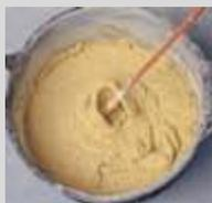
Amasar **weber.cal revoco** con 4,50-6,25 litros de agua limpia por saco, manualmente (a batidora eléctrica) o mecánicamente, hasta obtener una pasta homogénea.
