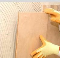
Colocar las baldosas presionándolas hasta conseguir el aplastamiento de los surcos del mortero cola y un buen macizado de la pieza. Comprobar periódicamente la pegajosidad de la pasta levantando la baldosa previamente colocada. Es aconsejable dejar juntas entre piezas colocando crucetas de 2 mm como mínimo en interiores y 5 mm en exteriores, rellenándolas con morteros de rejuntado de la **gama webercolor**.
