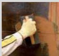
Aplicar en diagonal sobre las juntas presionando la masa sobre ellas con una llana de caucho y en paños pequeños. Eliminar el exceso de material con la misma llana.
