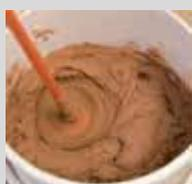
Amasar **webercolor hydroflex** con 3 litros de agua limpia por saco de 15 kg, manualmente o con un batidor eléctrico lento (500 rpm) hasta obtener una masa homogénea y exenta de grumos. Dejar reposar la mezcla dos minutos.
