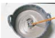
• Amasar weberfloor rapid con 4 litros de agua limpia por saco de 25 kg mediante batidor eléctrico o máquina de bombear hasta obtener una mezcla homogénea y sin grumos. Las propiedades de fluidez del producto deberán ser comprobadas mediante un ensayo de fluidez (180-200 mm de diámetro con el cono estándar Weber) antes y durante el bombeo, empleando un anillo medidor de flujo y una placa.
