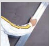
Reglear el material aplicado para regularizar el espesor y alisar la superficie.
