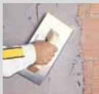
Amasar **webercal basic** con 4 - 5 litros de agua limpia por saco, manualmente (con batidor) o mediante máquina de proyectar, hasta su total homogeneización. Extender el producto
