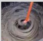
Amasar\* **webercol flex<sup>2</sup> duorapid** con 5 - 5,5 litros de agua limpia por saco de 25 kg con un batidor eléctrico lento (500 rpm) hasta obtener una masa homogénea y exenta de grumos.
