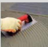
Extender sobre el soporte en paños pequeños y peinar con una llana dentada de 8x8 mm para regularizar el espesor de la aplicación.
